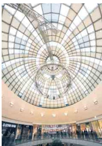
Die neue Leuchte ermöglicht erhebliche Stromeinsparungen, da sich die notwendige tageslichtabhängige Lichtintensität erstmals durch die Funktion der Dimmbarkeit steuern lässt. Die sogenannte Tag-/Nachtleuchte wird bei allen Neubau- und Umbauprojekten (u. a. im Phoenix-Center Harburg) für die Grundbeleuchtung in der Ladenstraße eingesetzt. Über die Ausführung in zwei Lichtfarben können über den Tag verschiedene Szenarien wie eine kühle Tages- und eine warme Abendstimmung geschaffen werden.
